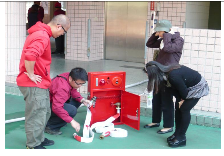
講解室內消防栓
